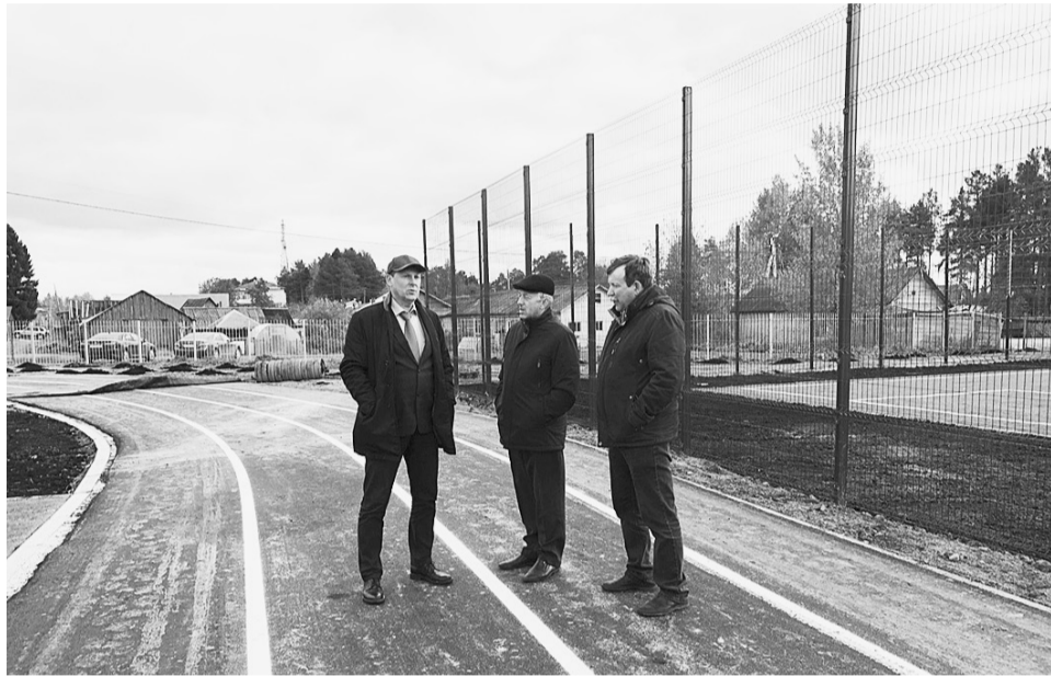
Сергей Фокичев проинспектировал строительство спортивного объекта в Сямже.
