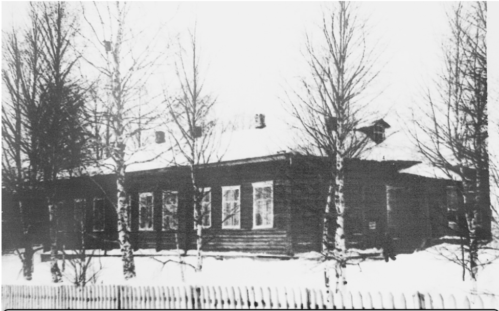
Старое здание школы, построенное в начале 30-х годов прошлого века.
