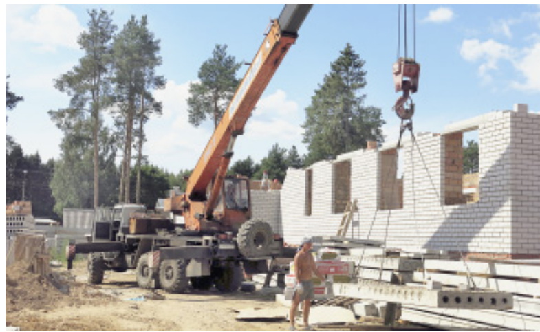
На стройплощадке в райцентре детского сада.
