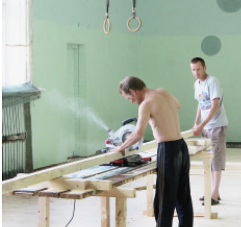
Ремонт в спортзале идет быстрыми темпами.
