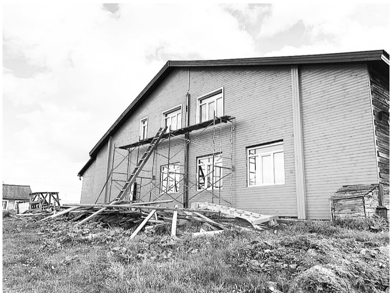
Обновлен фасад Гремячинского ЦК — здание обшили вагонкой.
