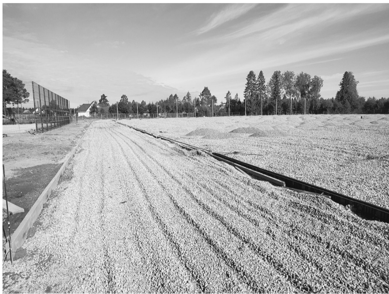
Подготовка основания беговой дорожки и большого футбольного поля.
