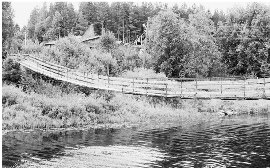
В планах — ремонт навесной лавы на крахмало-паточном.
