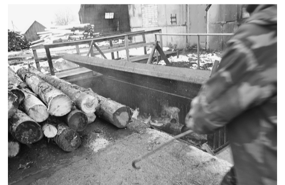
... и ознакомил с работой котельной.
