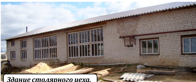
Здание столярного цеха.
