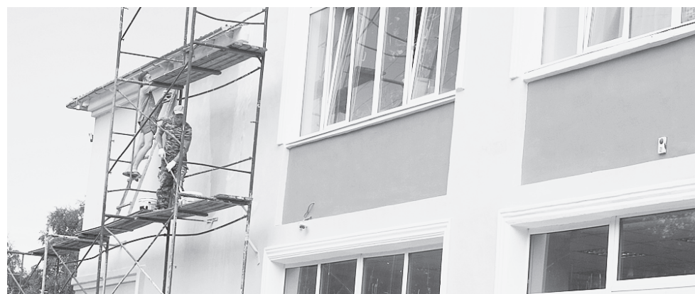
Во время ремонтных работ. Лето 2018 года.
