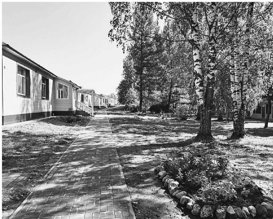
В уходящем году завершился ремонт Детского сада №1, летом здесь проводилось благоустройство территории.
