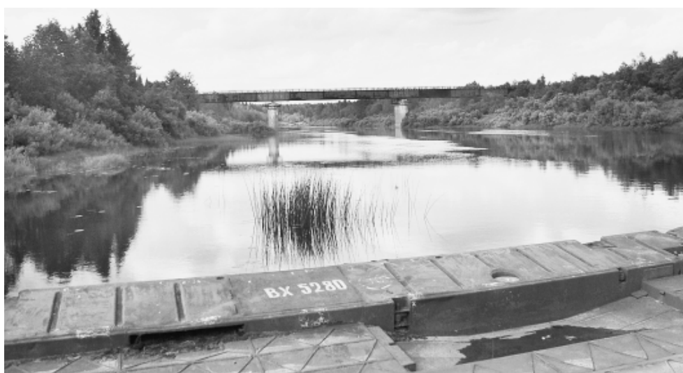
«Недостроенная мечта» - мост через Кубену.
